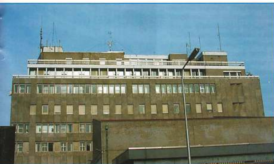
Het gebouw van het Kustwacht Centrum te IJmuiden
